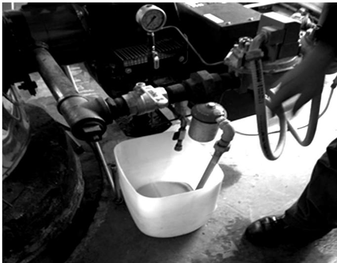
Figura 11. Arreglo para adicionar el biodiesel producido una vez se enciende la caldera con combustible ACPM.
